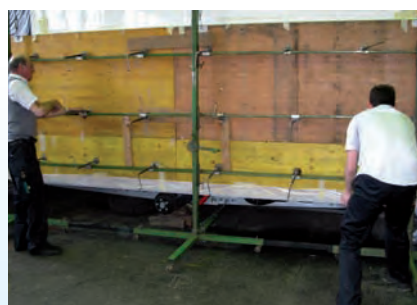
12. Anbringen der Anpressvorrichtung ...
