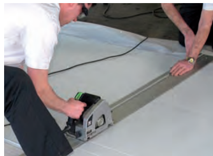
5. Blech wird auf Format gebracht
