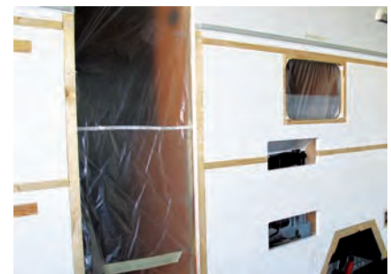
3. Vorbereiteter Caravan für die Neuverblechung
