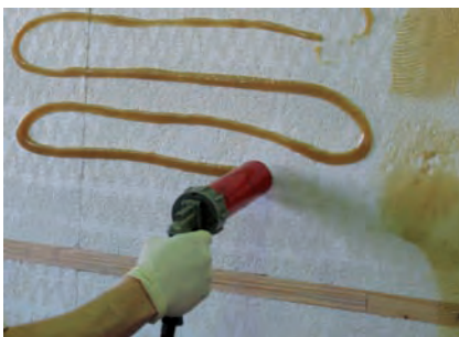
9. Jetzt wird der Kleber aufgetragen ...
