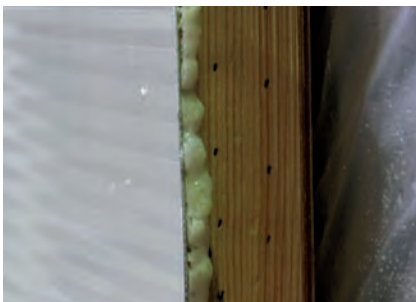
13.c. ... wie der Klebstoff sein Volumen erweitert und die Hohlräume füllt.
