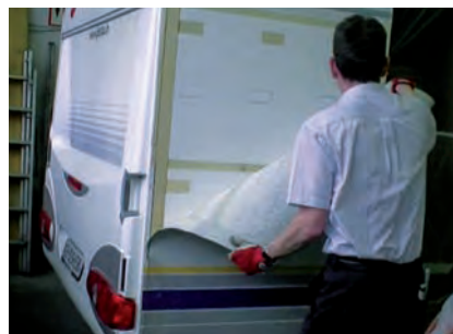
2. Abschälen des beschädigten Außenblechs
